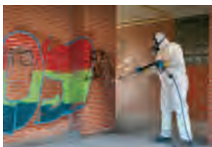
Un operario municipal limpia una pared.
