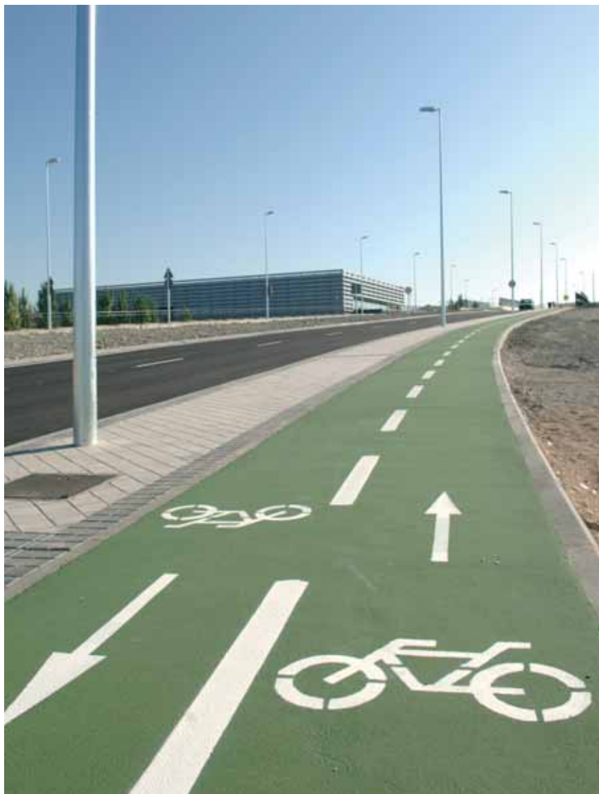
El carril bici del viaducto de la avenida Aurelio Álvarez, a su paso sobre la línea 9 de metro.
