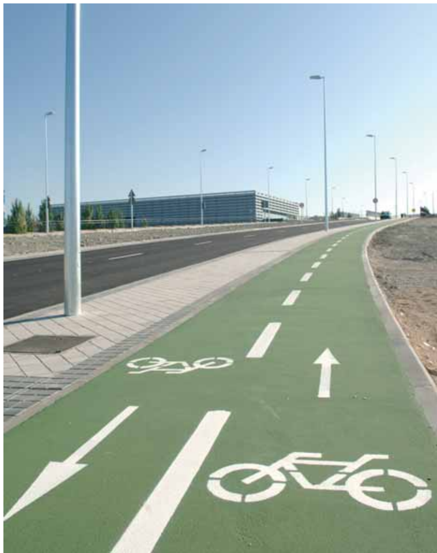
El carril bici del viaducto de la avenida Aurelio Álvarez, a su paso sobre la línea 9 de metro.
