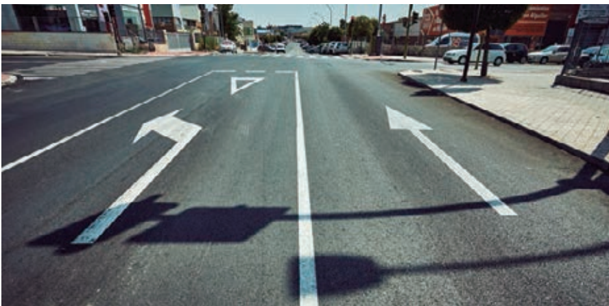
Uno de los cruces cuyos carriles se han desdoblado para mejorar el tráfico. L.G.C.
