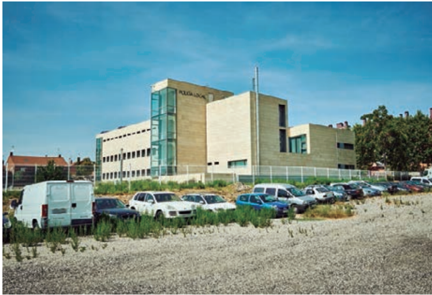
El nuevo depósito municipal de vehículos se sitúa ahora junto al edificio de Policía Local. L.G.C.
