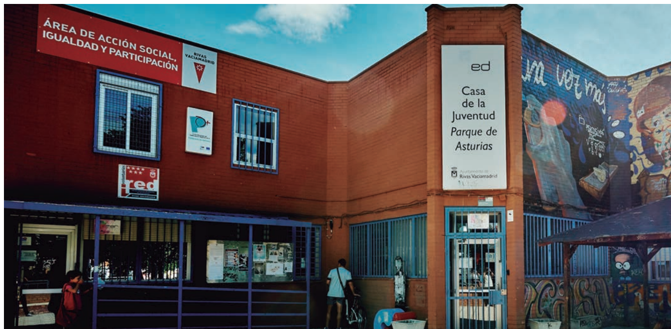
La nueva instalación se ubicará en el Área Social del Parque de Asturias. L.G.C.
