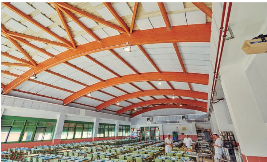
Entre las obras de 2017, la insonorización y mejora acústica del comedor del colegio José Hierro. L.G.C.
