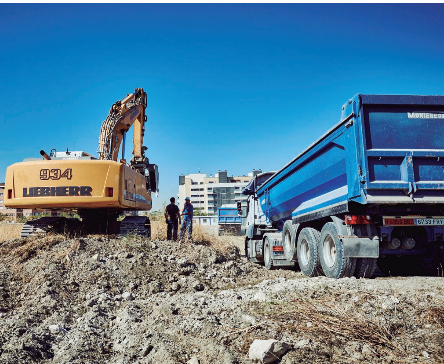
Inicio de obras del futuro centro deportivo del barrio de La Luna.
