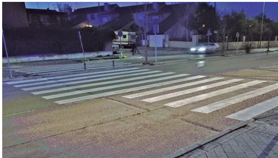
Nuevo paso de cebra asimétrico, en una calle de Rivas.
