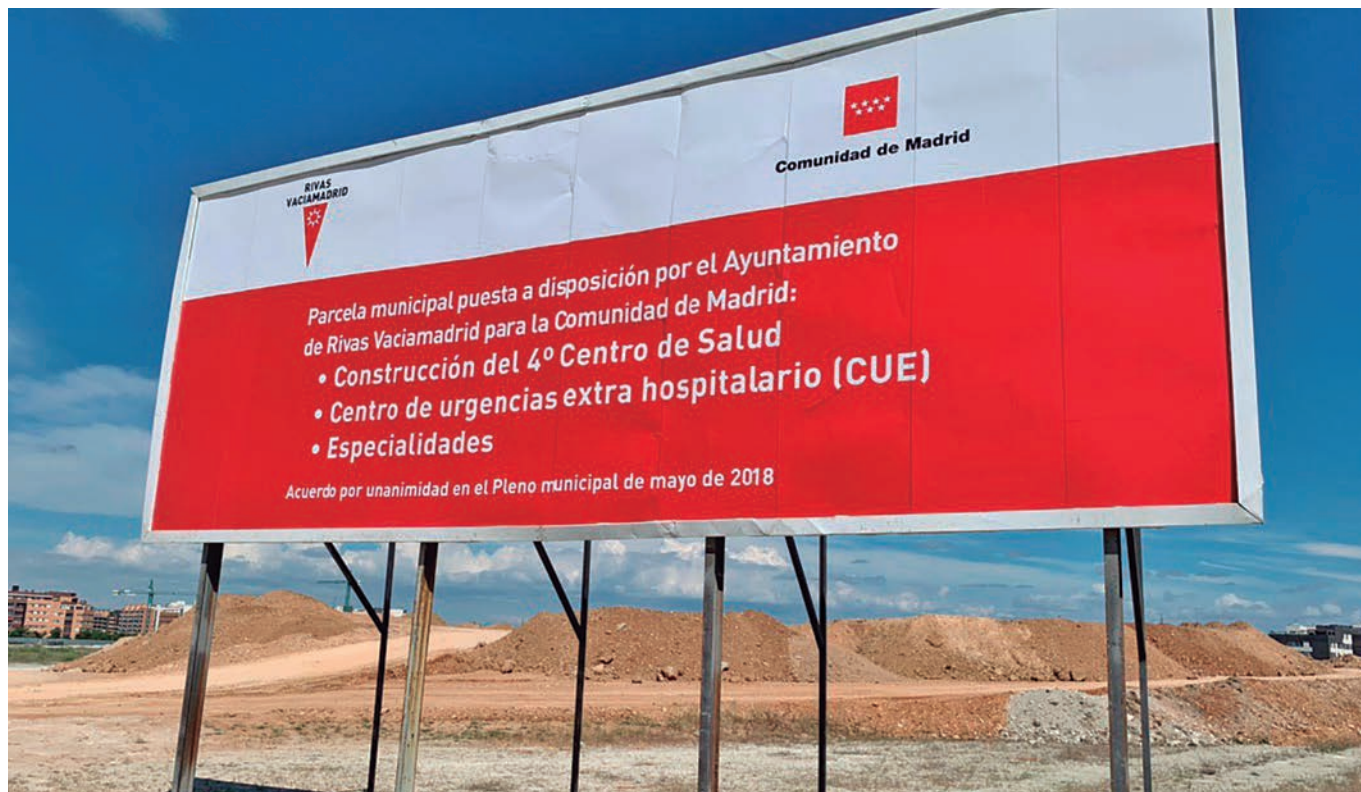
Parcela con el cartel informativo de obra en la zona donde se levantará el cuarto centro sanitario del municipio.
