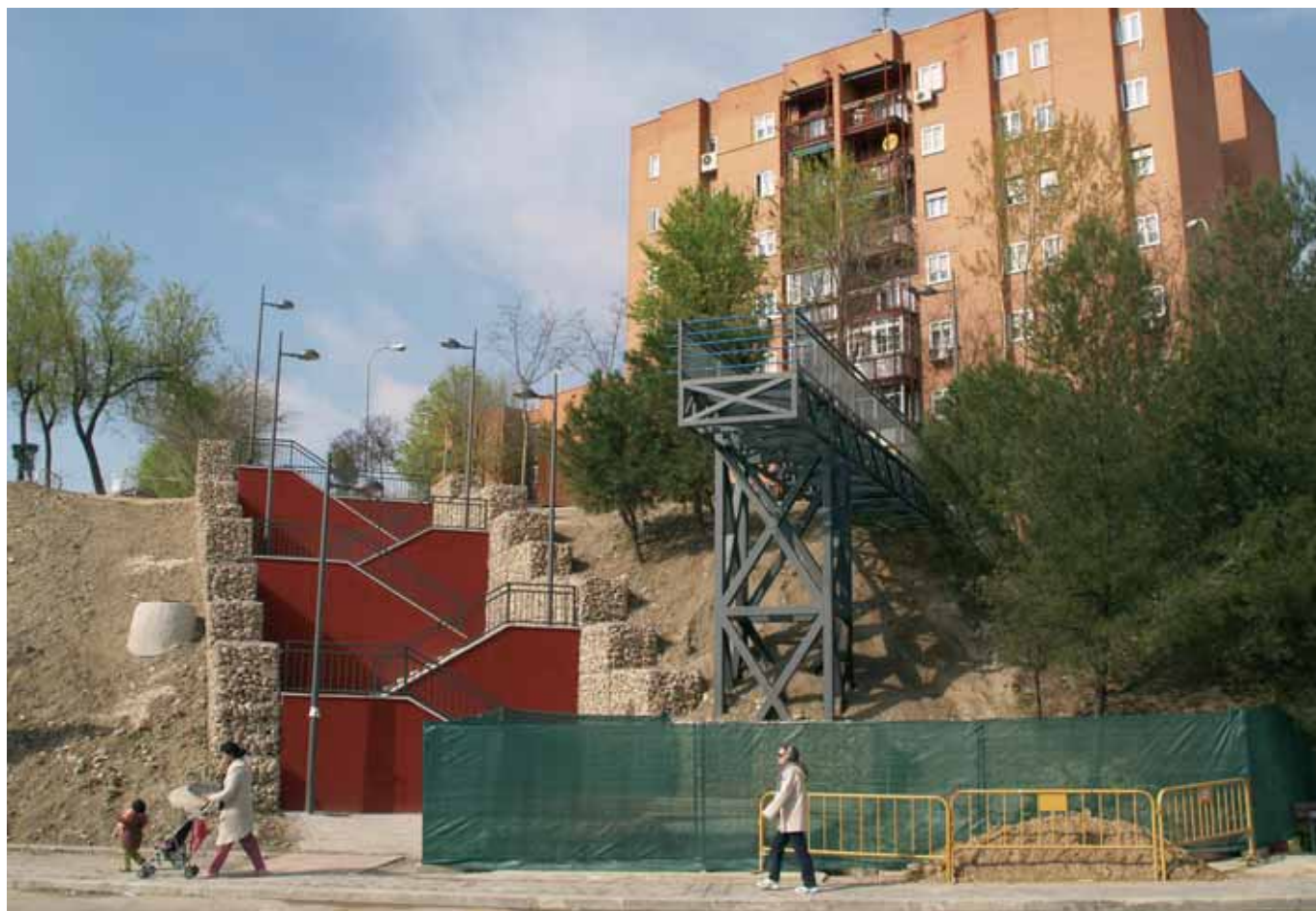
La escalera de la avenida de Covibar, ya abierta, de rojo. A su derecha, la plataforma sobre la que descansará el futuro elevador.
