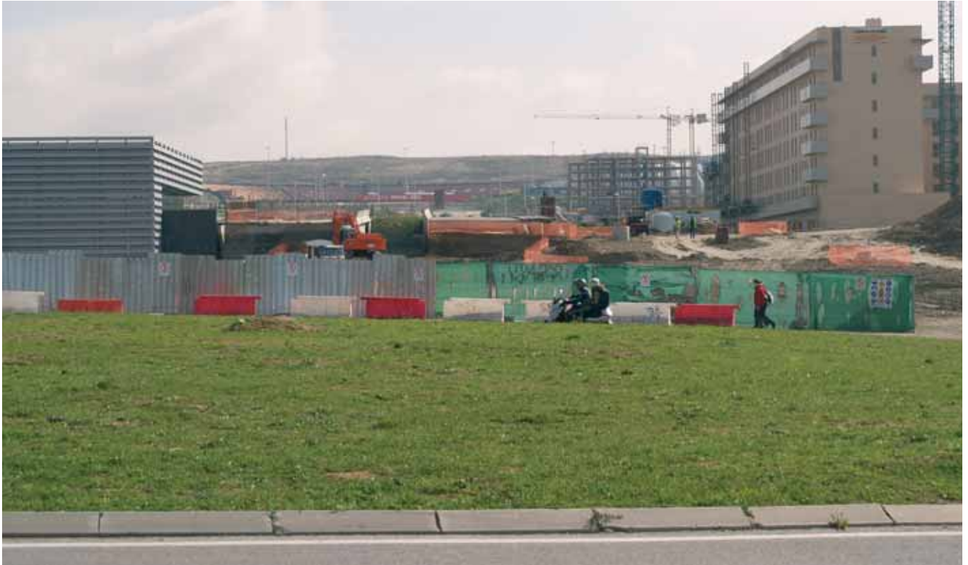
Una excavadora, sobre el futuro viaducto que pasa por encima de las vías del tren, y que ahora interrumpe el paso por la avenida Aurelio Álvarez. A la izquierda, el lateral de la estación de metro Rivas Futura. Al fondo, de rojo, el auditorio Miguel Ríos.
