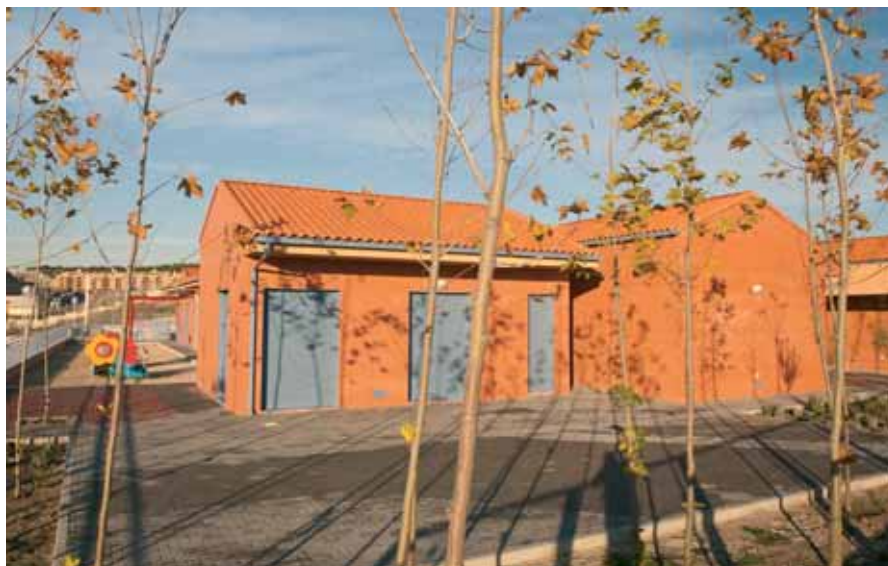
La escuela Nanas de la Cebolla, antes de finalizar las obras, en noviembre de 2010.
