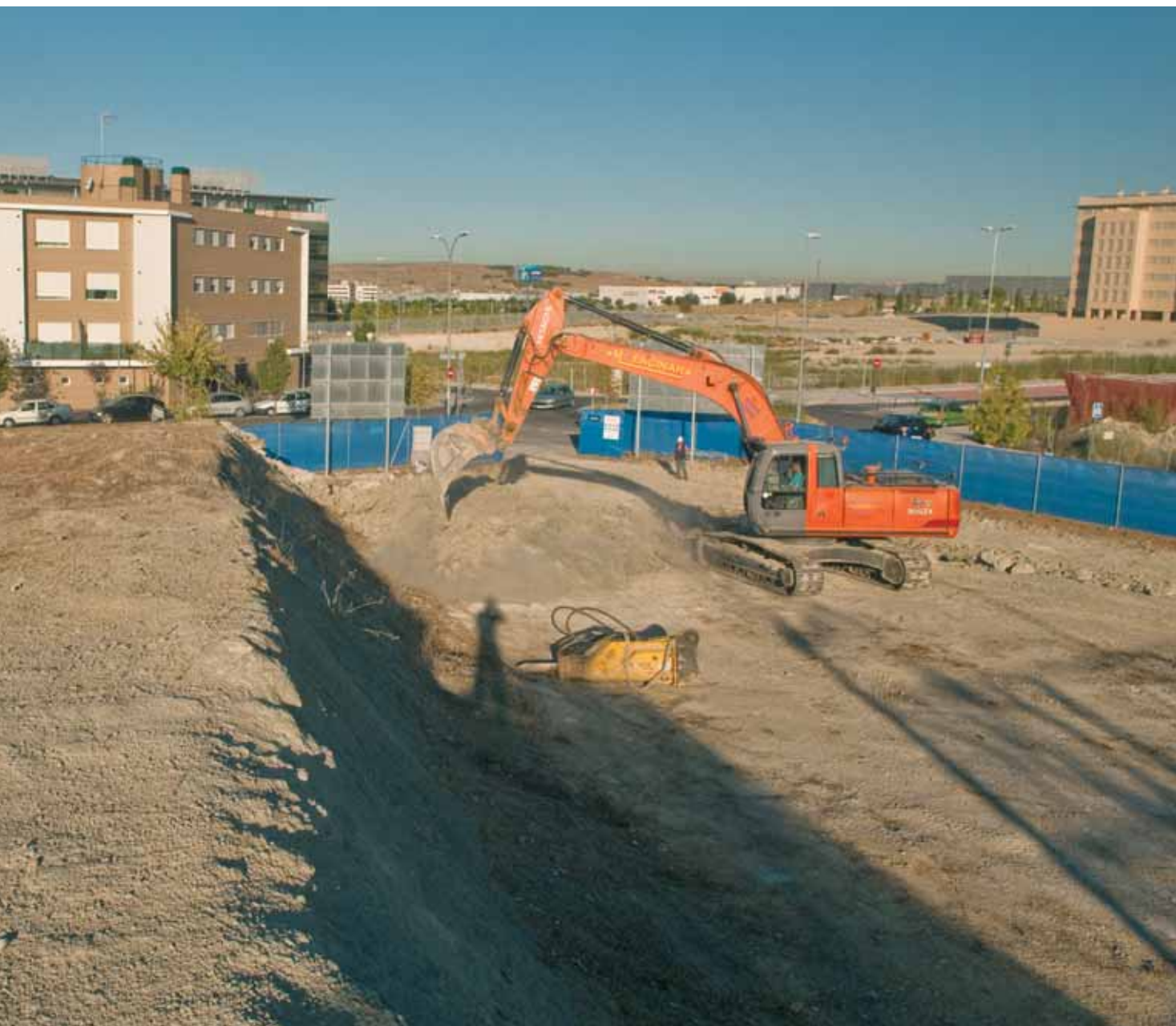
Una excavadora remueve, el pasado 12 de septiembre, la tierra en la parcela donde se construye el tercer centro de salud de Rivas.
