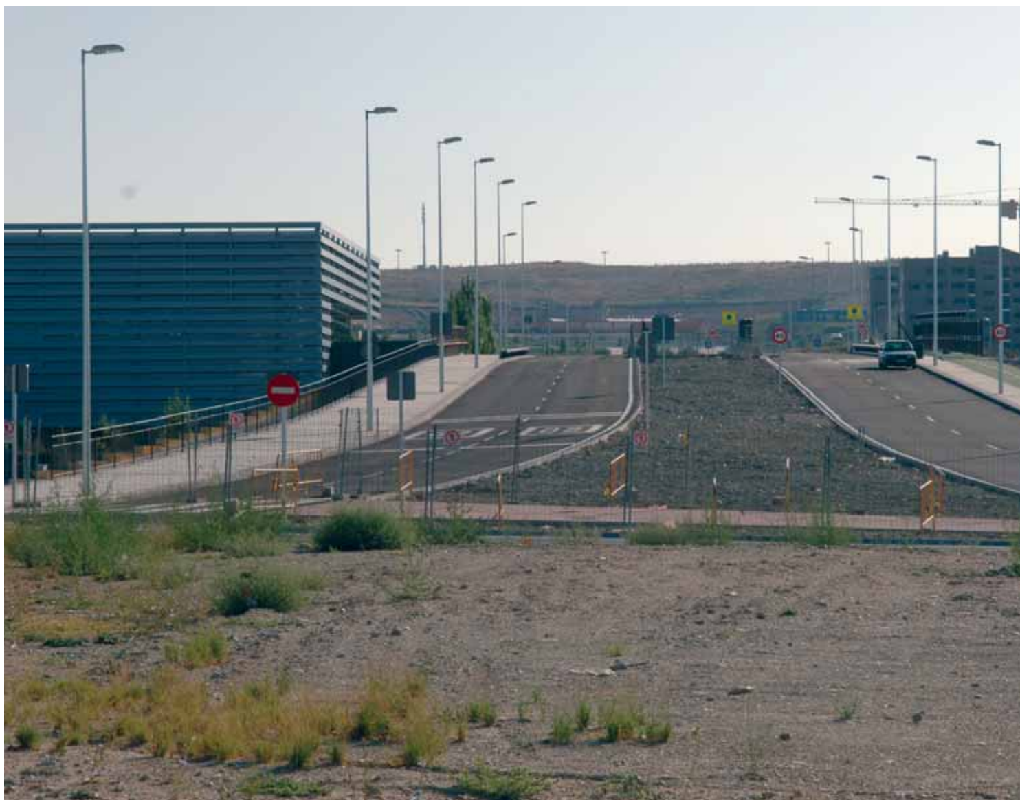
El viaducto, los últimos días de las obras, el pasado 23 de agosto. El puente incluye cuatro carriles para vehículos y un carril bici.
