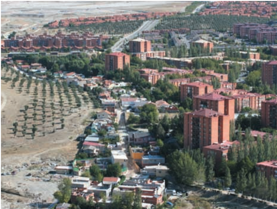
Vista aérea de la Cañada Real en el tramo que cruza el término municipal de Rivas.
