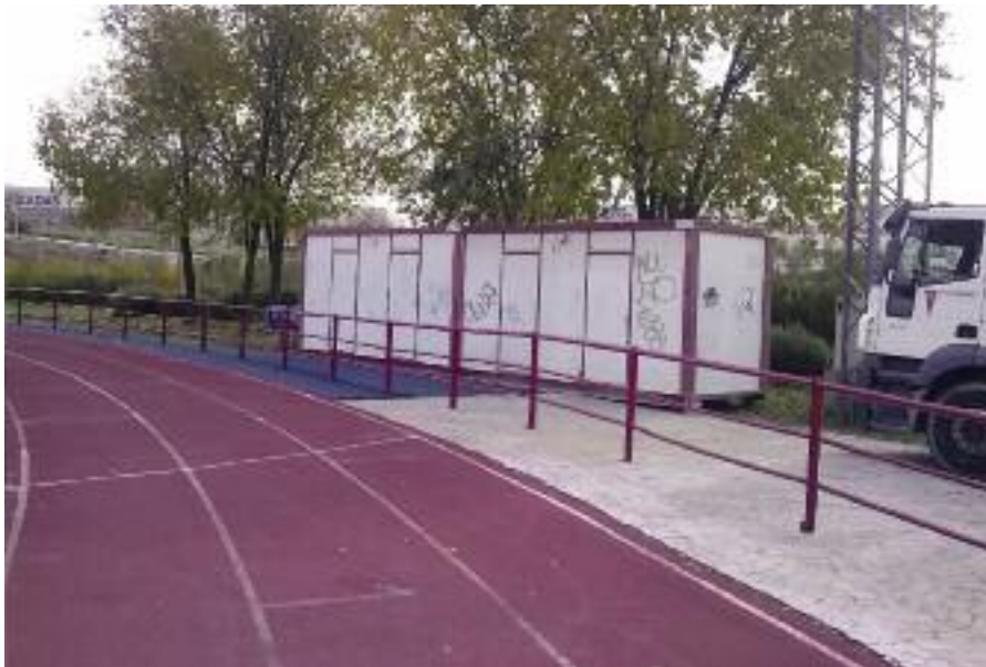
Dos de las casetas ubicadas en el estadio de atletismo del Cerro del Telégrafo.
