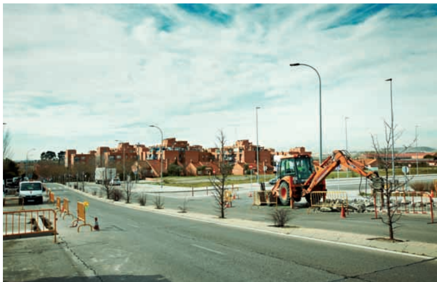
Obras en la intersección del paseo de las Provincias con la avenida de la Tierra. LUIS GARCÍA CRAUS.
