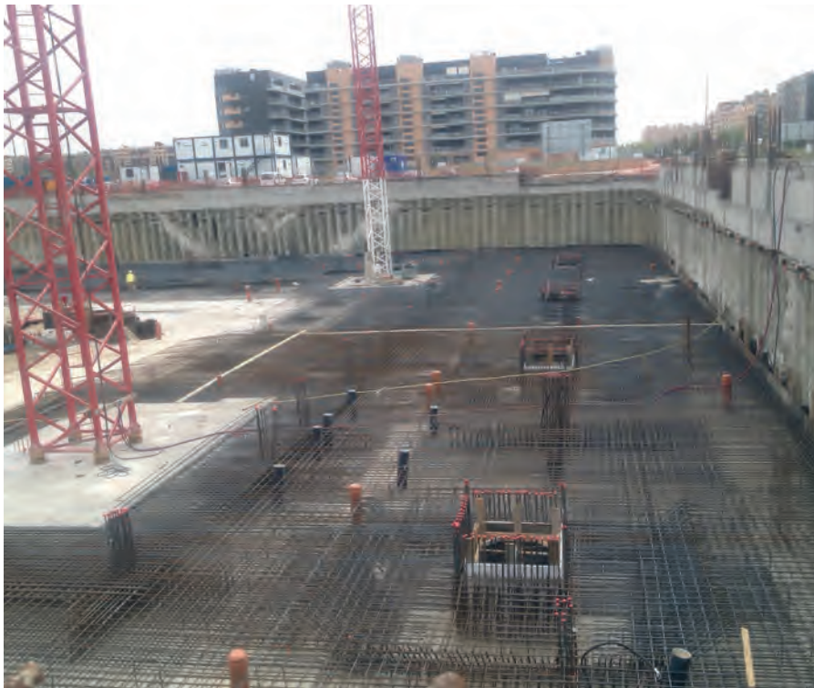
Estado avanzado de las obras del VI Plan, que estará finalizado en mayo de 2016.
