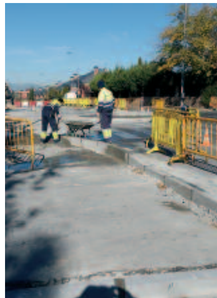
Operarios municipales, en los trabajos de la rotonda. CONCEJALÍA DE MANTENIMIENTO
