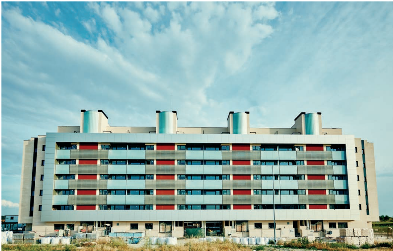
Edificio correspondiente al sexto plan de vivienda, en el barrio de La Luna, con las obras a punto de finalizar. L.G.C.
