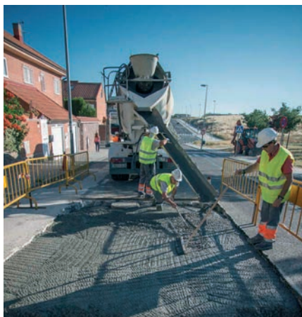
Trabajo de asfaltado en una vía de Rivas.
