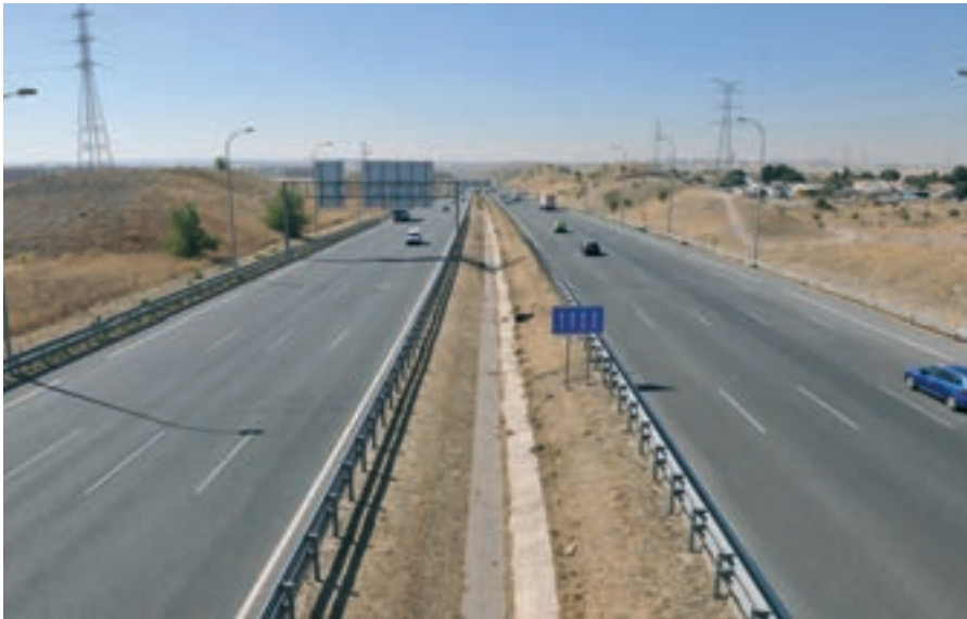
Tramo de la M-50 a su paso por Rivas. L.G.C.
