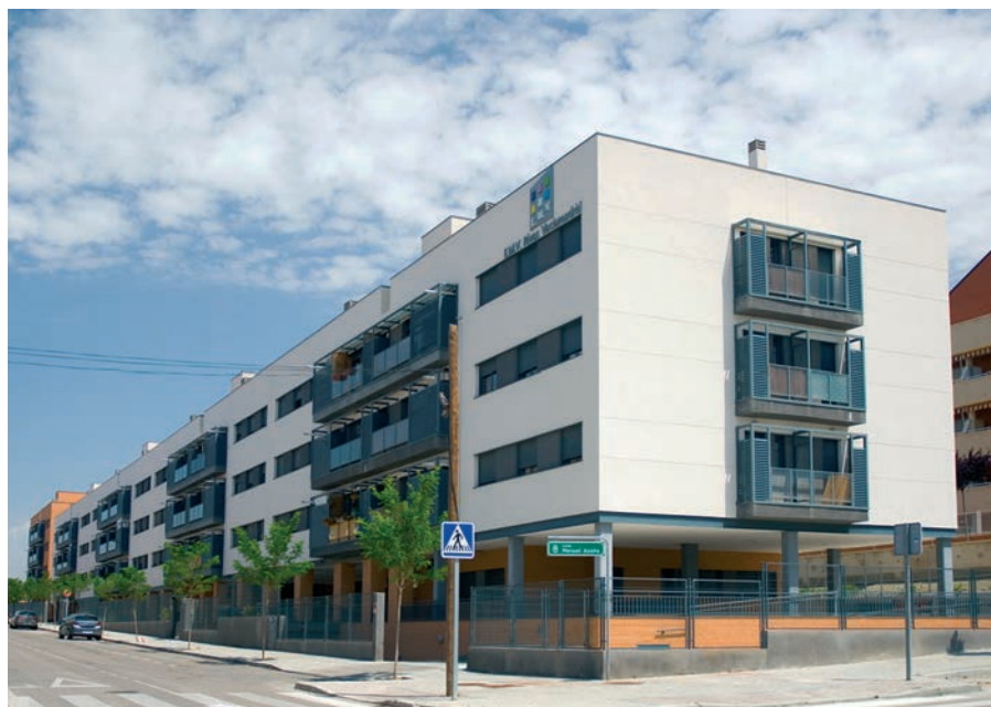
Edificio de viviendas en alquiler de la EMV, en la calle Manuel Azaña. EMV RIVAS
