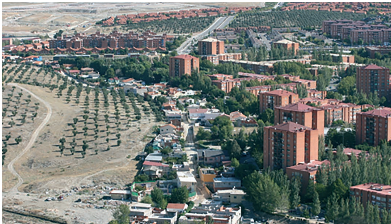
El sector 3 de la Cañada Real, colindante con el barrio de Covibar, en la zona oeste de Rivas.
