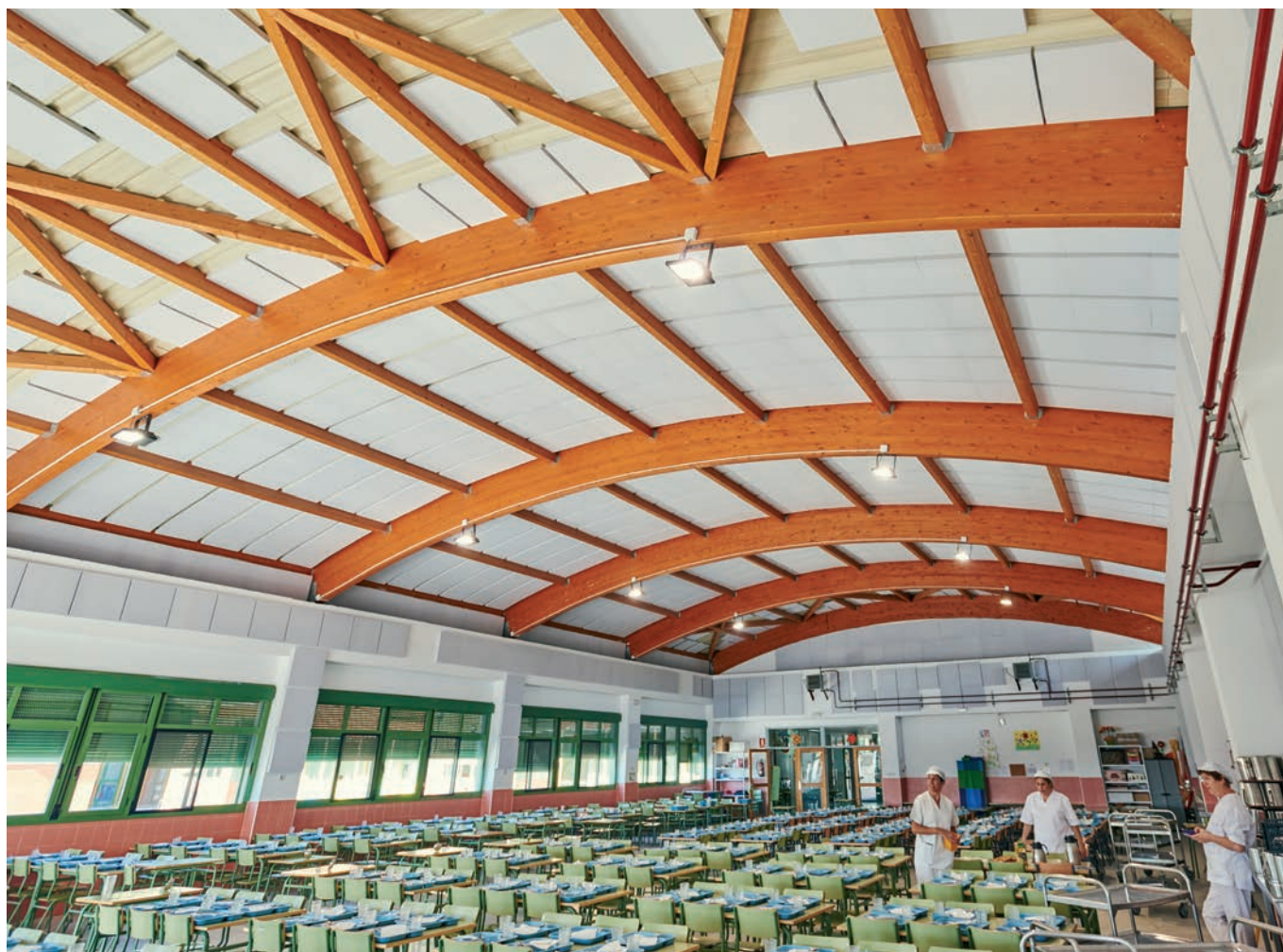
Comedor del colegio José Hierro tras las obras que mejoraron su acústica.
