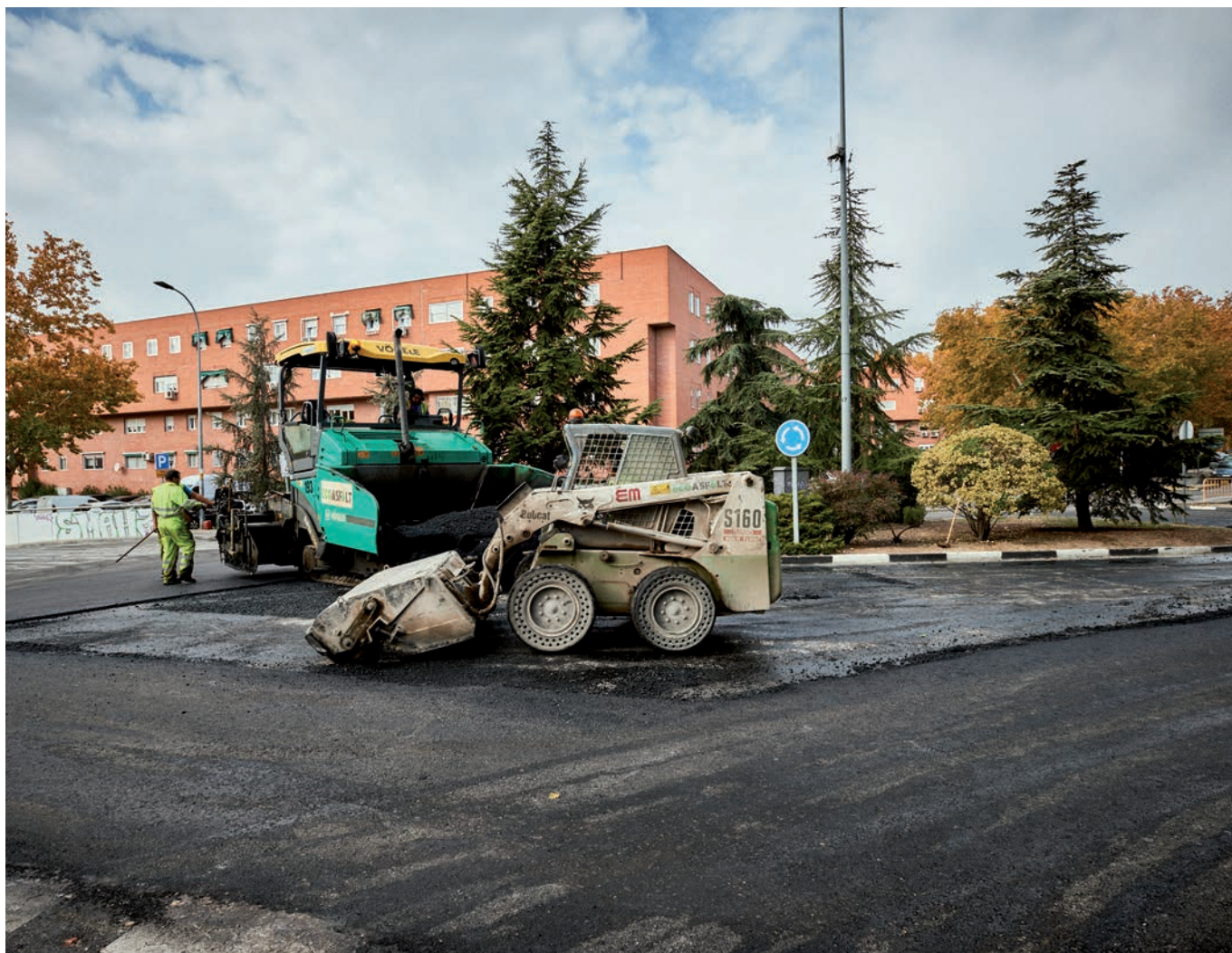
Trabajos de asfaltado, en noviembre, en la zona de Covibar.
