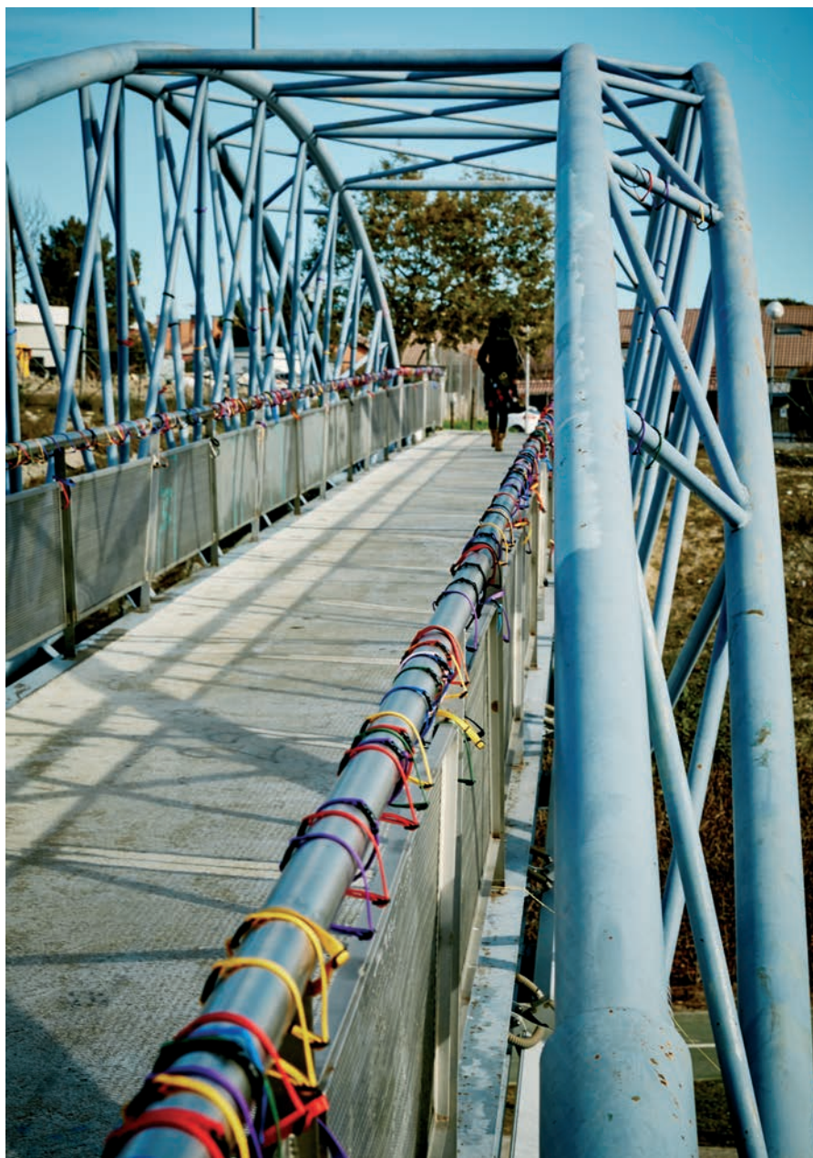
'El puente de los collares', pasarela sobre el parque Lineal. LUIS GARCÍA CRAUS
