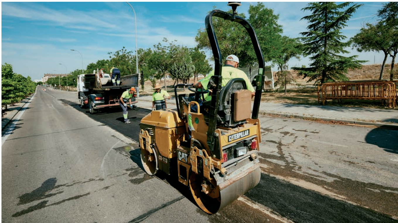
Operarios municipales asfaltan un tramo de la avenida de las Provincias, en mayo. L.G.C.
