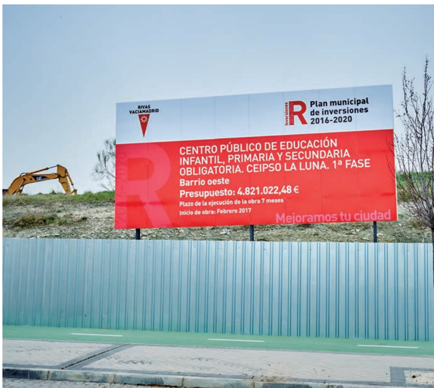
Dos imágenes de las obras iniciadas en febrero para construir la primera fase del CEIPSO La Luna.
