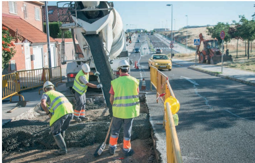
Personal municipal durante unos trabajos de asfaltado en 2013. ESTÁXVER
