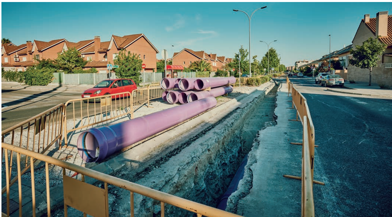
Obras de canalización para crear la red de 50 km que permitirá regar con agua no potable todos los parques y jardines de la ciudad. L.G.C.
