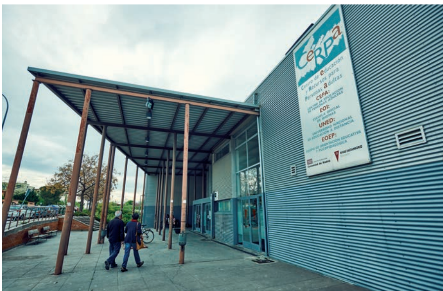
Edificio del CERPA, que acoge las enseñanzas de la UNED en Rivas. L.G.C.
