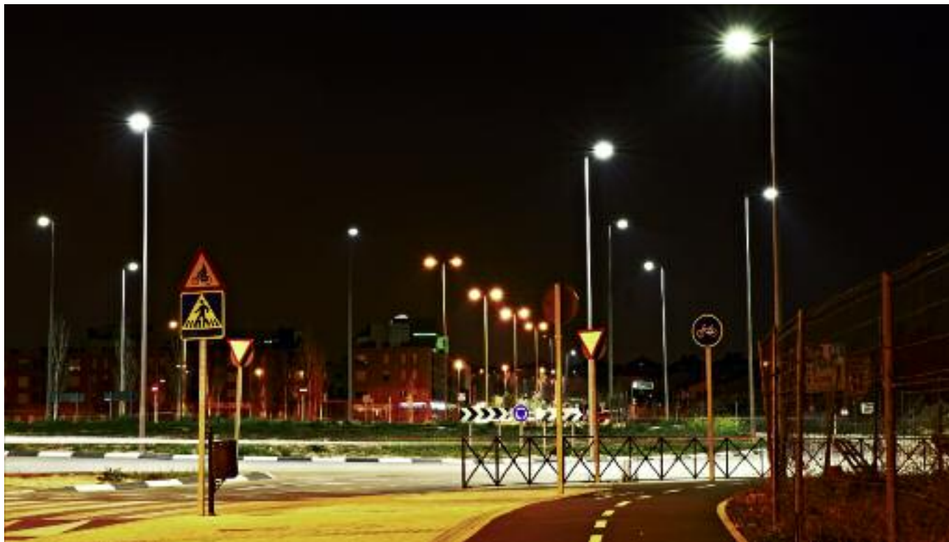
Luminarias led en Rivas, un sistema limpio de energía. L.G.C.
