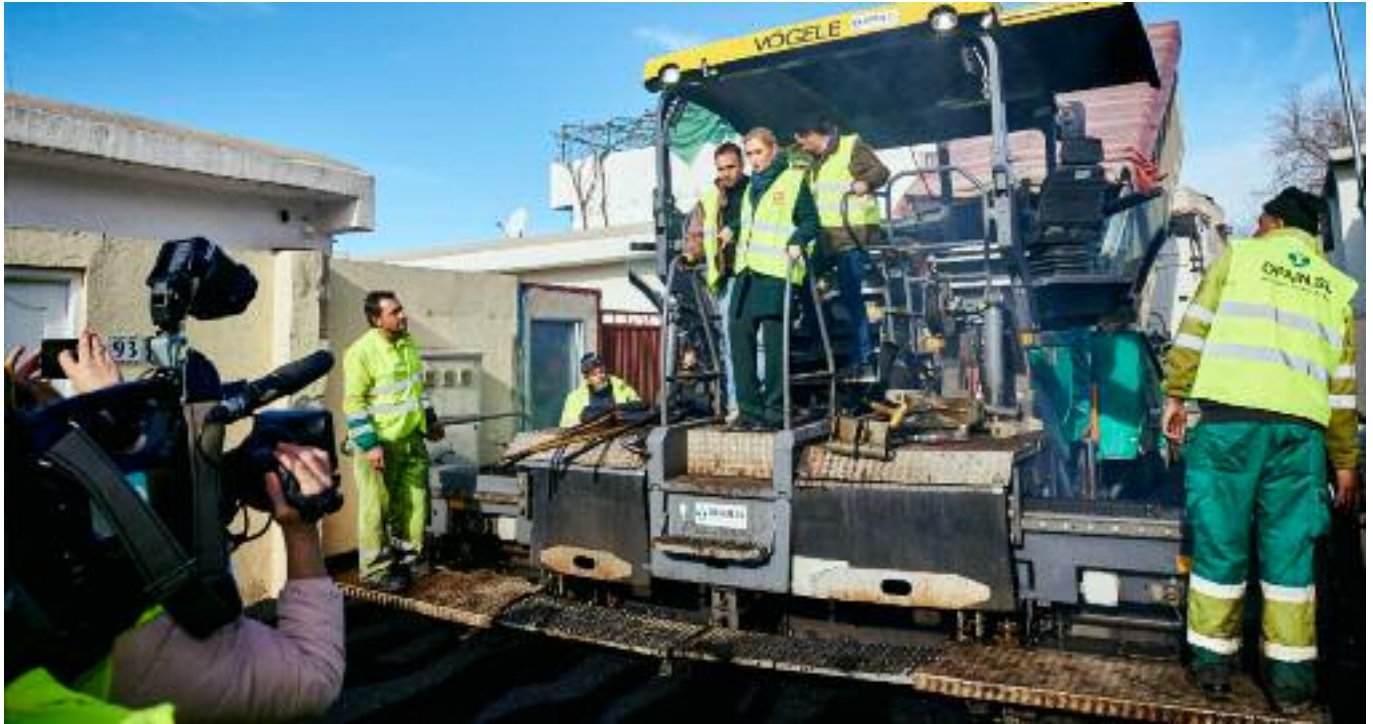
La presidenta autonómica, Cristina Cifuentes, subida a la máquina con la que se asfaltó una vía de la Cañada Real, a su paso por Rivas, en diciembre. L.G.C.
