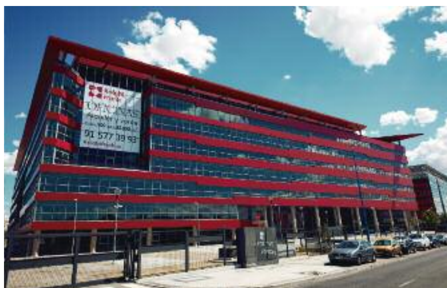
Edificio del complejo empresarial Rivas Futura que albergaba la sede de Idental en la localidad. L.G.C.
