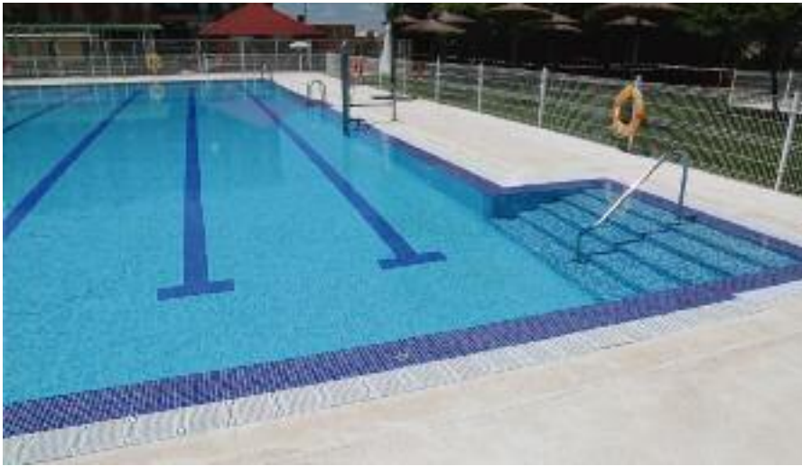
El vaso grande de la piscina municipal incorpora una nueva escalera que facilita el ingreso al agua a personas con movilidad reducida. P.V.
