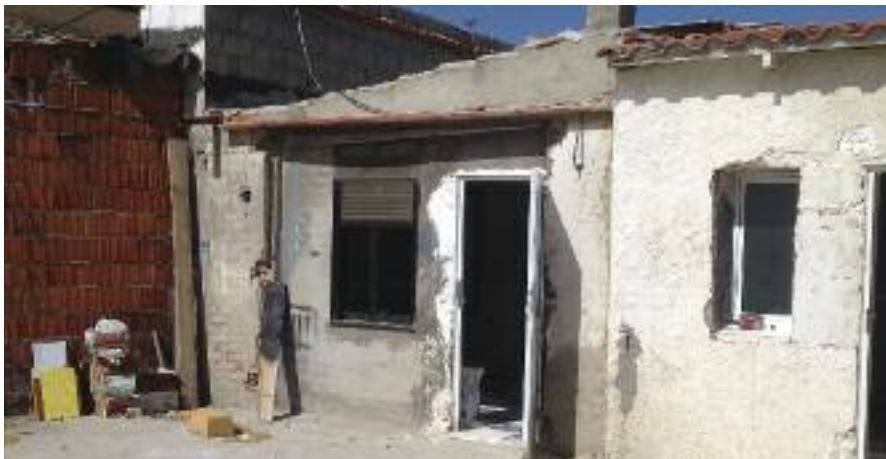
Una de las viviendas ilegales derribadas, el pasado mes de abril, en la Cañada Real.
