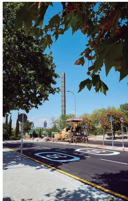
Un momento de las obras del paso elevado. L.G.C.
