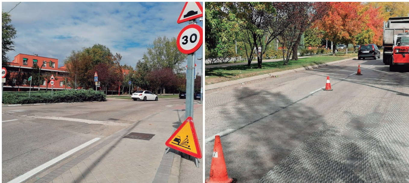
Actuaciones de asfalto que comenzaron a finales del pasado octubre. Se está interviniendo por toda la ciudad.
