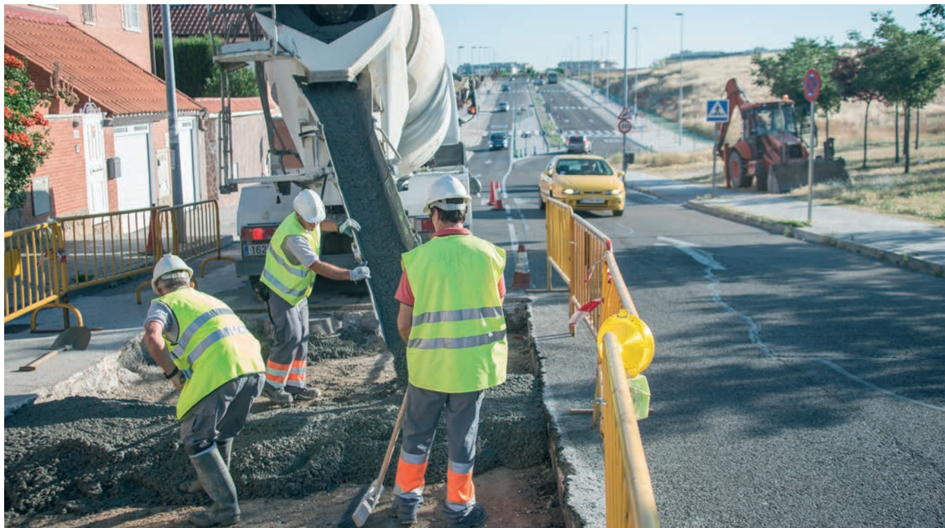
Imagen de archivo de unos trabajos de asfaltado en una calle ripense, en 2017. LUIS GARCÍA CRAUS
