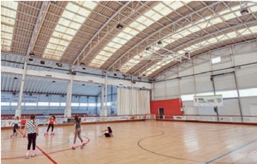
Centro de patinaje del polideportivo municipal Cerro del Telégrafo. L.G.C.
