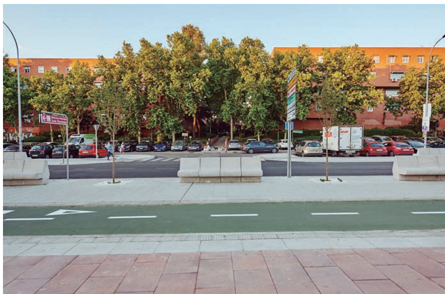
Trabajos de renovación y ampliación de aceras en Covibar en 2018. LUIS G. CRAUS
