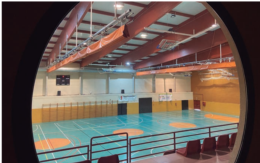
El pabellón del polideportivo municipal Parque del Sureste, cuya cubierta se ha remodelado. H.X.J.
