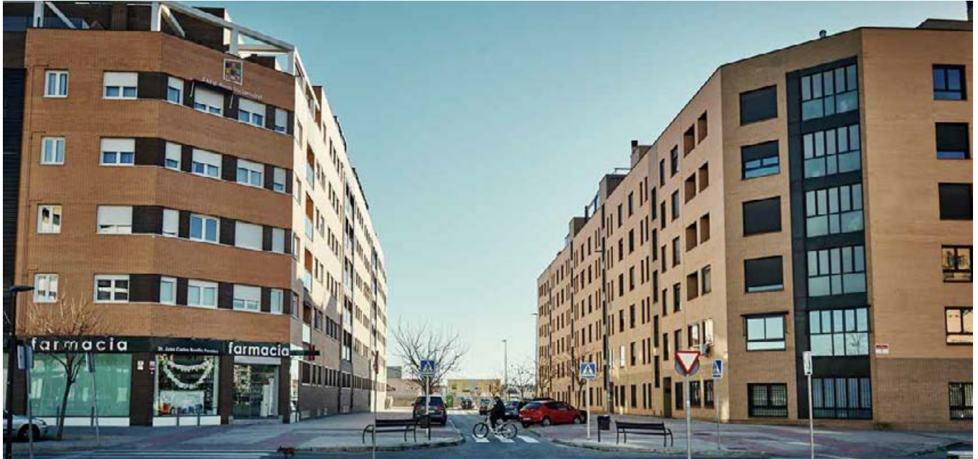
Edificios residenciales promovidos por la Empresa Municipal de la Vivienda (EMV). L.G.C.
