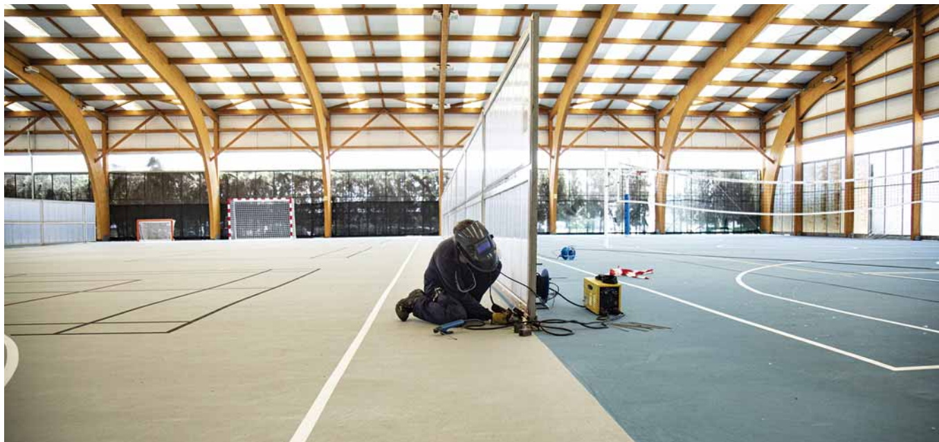
Un operario realiza trabajos de adaptación en el pabellón de las pistas semicubiertas del polideportivo Cerro del Telégrafo. MARIO FDEZ TREJO
