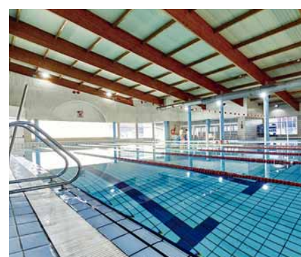
La piscina climatizada del Cerro del Telégrafo.
