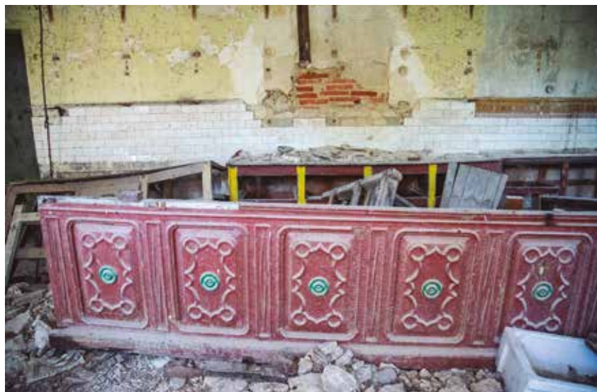
Restos de la antigua cantina, entre los que se conserva entre ruinas el mostrador.
