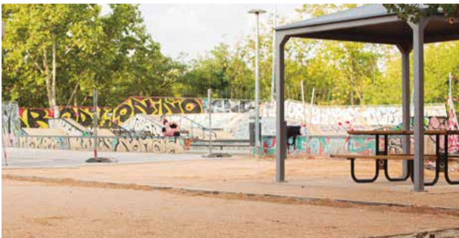
La nueva pista de petanca del parque de Asturias, en la última fase de los trabajos de obra, a finales de agosto: estará vallada y contará con una pérgola y mesa de merendero. RAQUEL MUÑOZ
