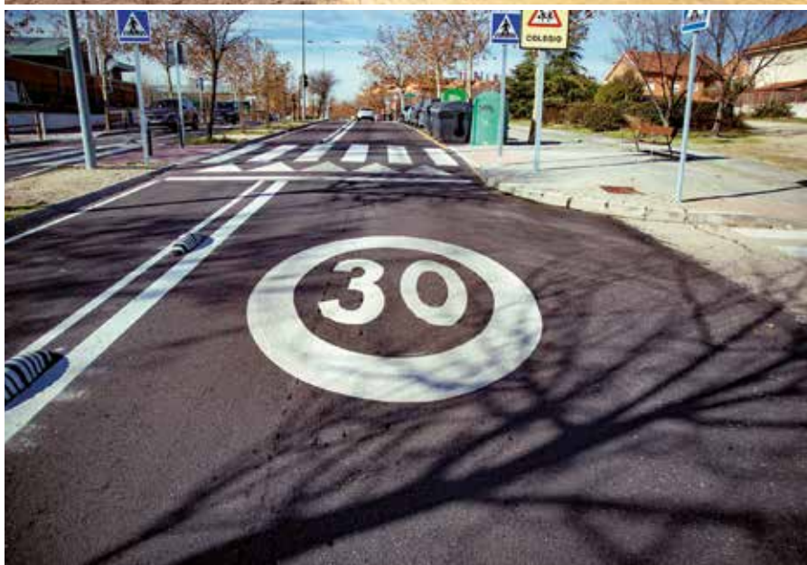
Rivas viene invirtiendo en la mejora de su escena urbana, con actuaciones por todo el municipio (en la foto de arriba, nueva zona estancial en actuación urbana en el barrio de La Luna estrenada en 2023). Abajo, calle recién asfaltada en 2023. PAULA G. MONTEJO y MARIO FDEZ. TREJO
