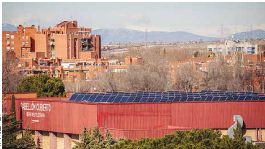
Arriba: integrantes de la comunidad energética de Rivas, el pasado 24 de octubre, en el Ayuntamiento. Abajo: placas solares en el pabellón del polideportivo Cerro del Telégrafo.
