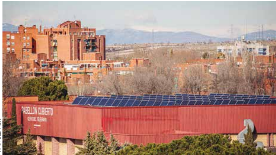
Arriba: integrantes de la comunidad energética de Rivas, el pasado 24 de octubre, en el Ayuntamiento. Abajo: placas solares en el pabellón del polideportivo Cerro del Telégrafo.
