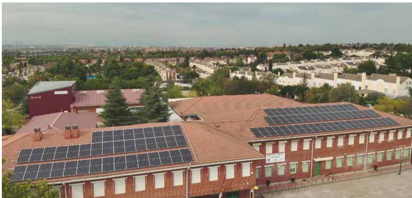
Rivas es ciudad puntera en dotar a sus centros educativos de paneles fotovoltaicos, como estos del colegio público Jarama.
