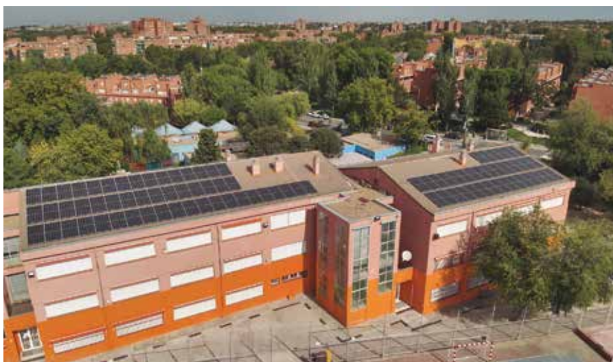
Paneles solares en el colegio público La Escuela.
