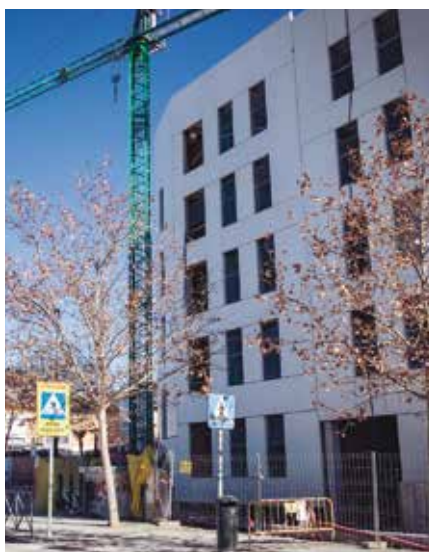
El edificio con 83 viviendas para jóvenes que construye la EMV de Rivas, el pasado enero. M.T.
