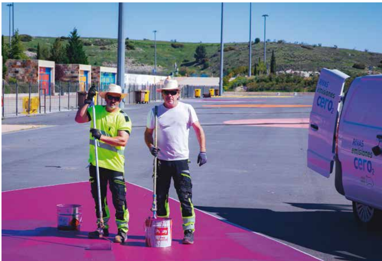
José y David, dos operarios de la Concejalía de Mantenimiento, llevan semanas señalizando con pintura de colores el suelo del recinto ferial.
