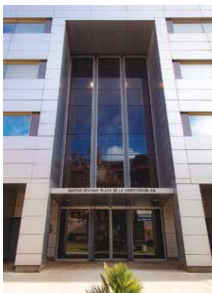
Fachada de entrada a la futura Escuela Municipal de Música. M.F.T.
