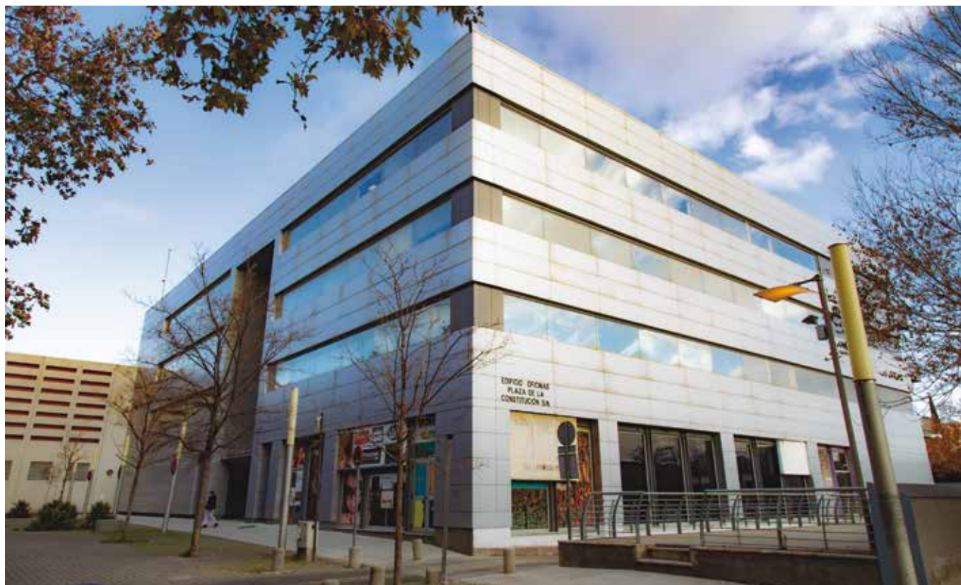
El edificio adquirido por el Ayuntamiento donde se ubicará la nueva sede de la Escuela Municipal de Música. MARIO FDEZ. TREJO
