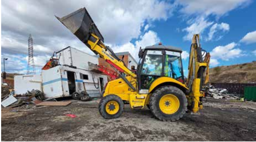
Una excavadora, durante la operación en realizada el pasado 21 de noviembre en la Cañada Real.
