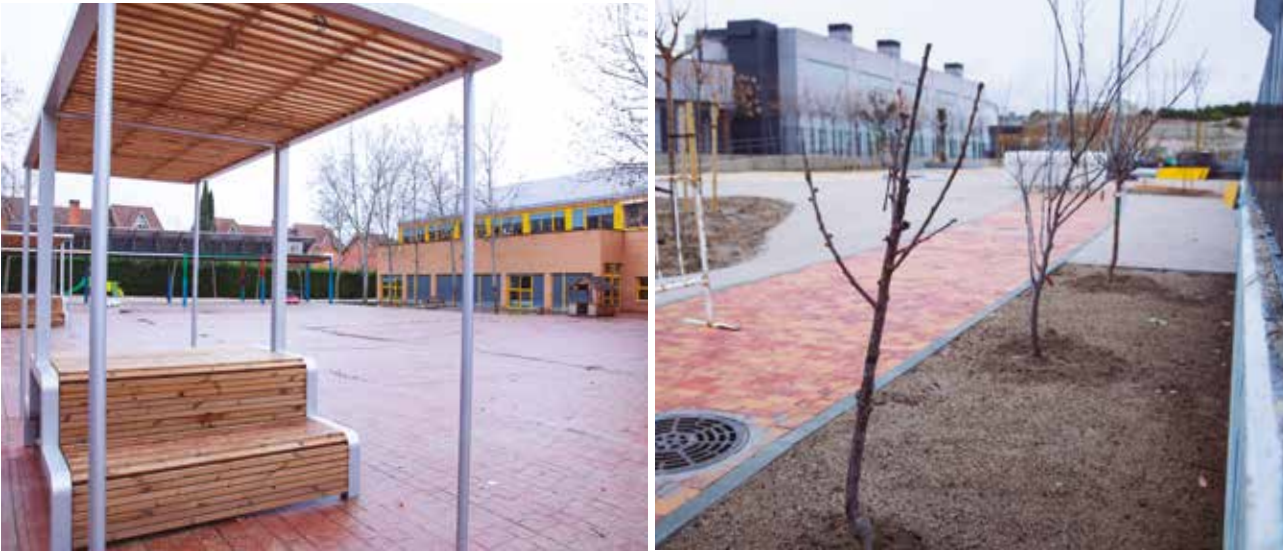
Sombreado instalado en el CEIP José Saramago y obras de Renatura en el entorno del CEIPSO La Luna.
