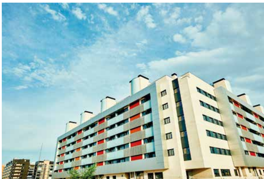
Edificio de viviendas promovido por la EMV de Rivas. LUIS GARCÍA CRAUS
